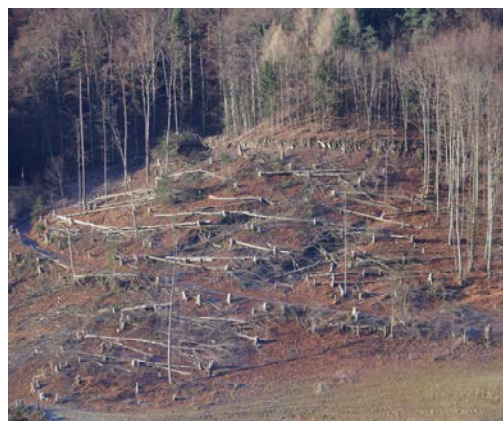
Sicherheitsholzschlag in Oberdorf am Wintenberg mit quergefallenen Bäumen als Steinschlagschutz. Das letzte Bild zeigt den selben Hang im Herbst ein Jahr später.
